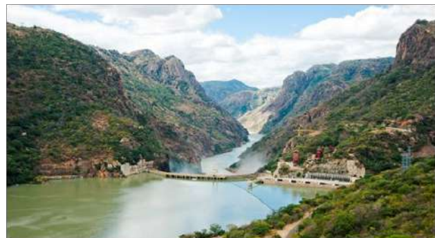
Figura 14. Aproveitamento hidroelétrico de Cahora-Bassa. Vistas de jusante, à esquerda, e de montante, à direita.
